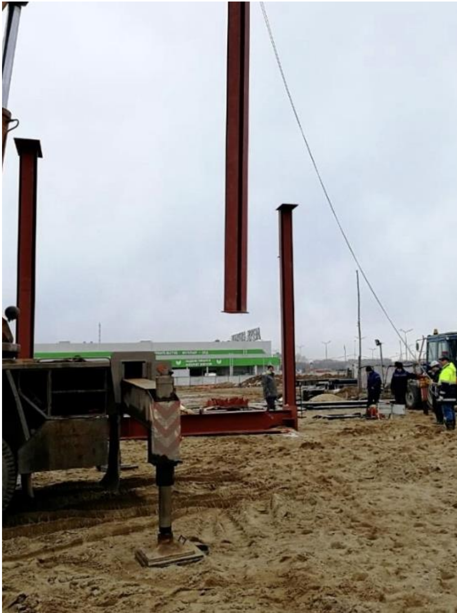
06.04.2021 г. – установка первой сваи
